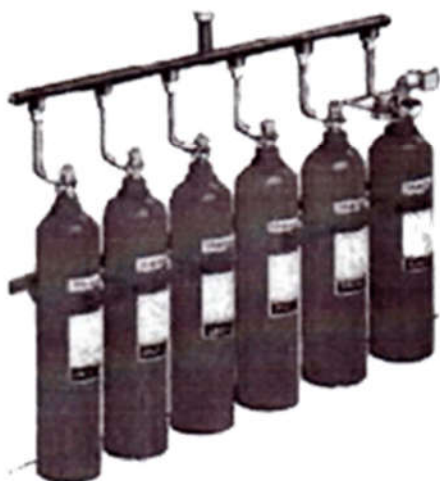
батарея газового пожаротушения (ГОТВ - Инерген)
